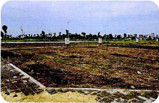
Hình 8.3. San lấp mặt bằng khu đô thị
