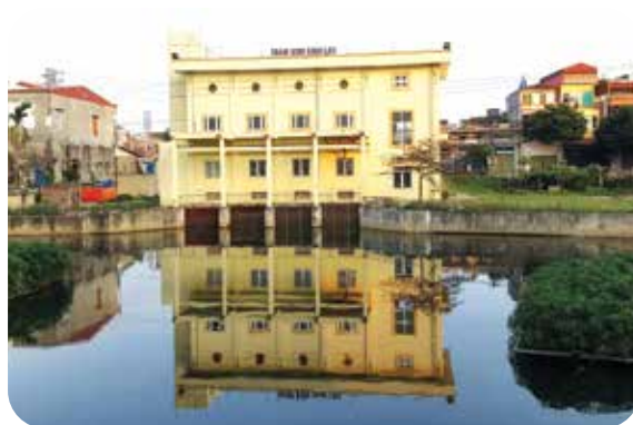
Hình b. Trạm bơm Bình Lâu (thành phố Hải Dương)
