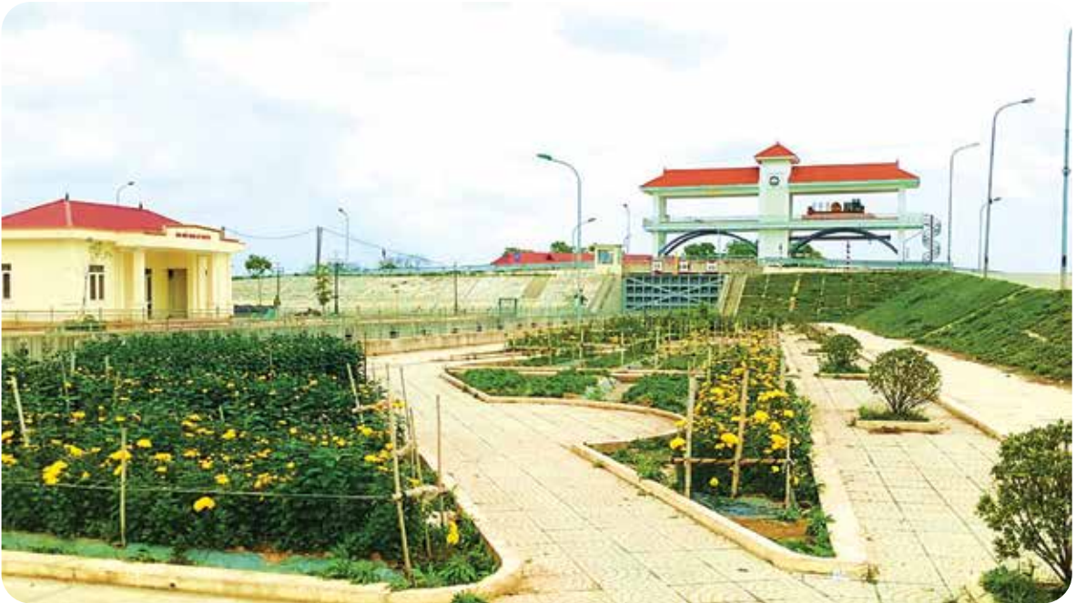
Cống Cầu Cát (thành phố Hải Dương)
